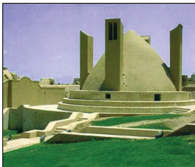
Рисунок 5. Цистерна, вентилируемая и охлаждаемая с помощью ветроуловителя
