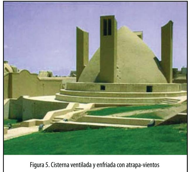
Figura 5. Cisterna ventilada y enfriada con atrapa-vientos
