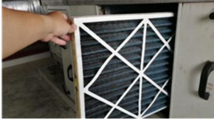
Resim 3.12: Klima santralinde örnek filtre değiştirme şekli
