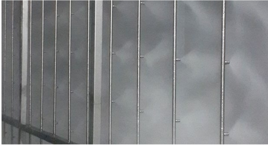
Resim 3.26: Yüksek Basınçlı Su Kullanan Nemlendirici Uygulama ۖrneęi
