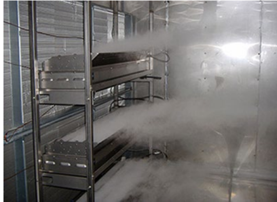
Resim 3.29: Ultrasonik Nemlendirici Çalışma Prensibi ve Uygulama Örneği
